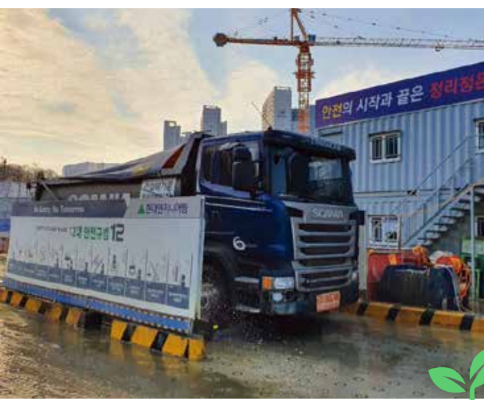
비산먼지 발생 사업장 관리(감일지구 공사 현장)
